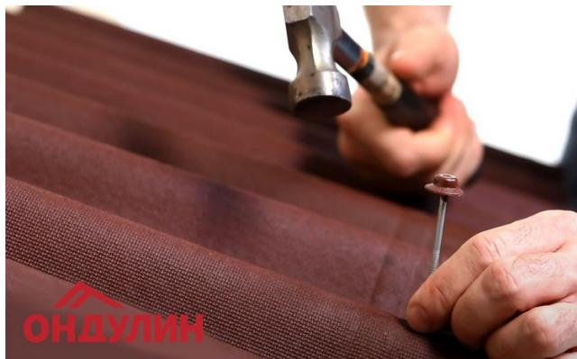
Кровельный гвоздь вбивается в верх волны. Поэтому, во время таяния снега или во время дождя вода стекает вниз. Сами же шляпки гвоздей имеют герметичное соединение за счёт битума. Это значительно надежнее, в сравнении с использованием кровельных саморезов, которыми крепят металлические листы в нижнюю часть волны. Тут вероятность протечек высокая, особенно если осмотр крыши и подтяжку саморезов не делать регулярно.
