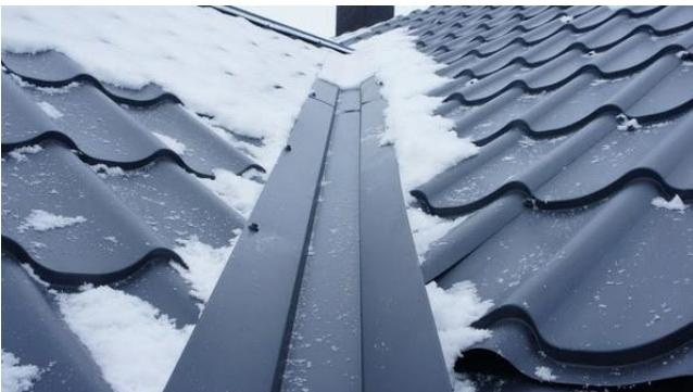
Так называется конструктивный элемент крыши, образующий внутренний угол. Ендова испытывает большую нагрузку от атмосферных осадков и по этой причине в таких местах часто образуются протечки. Ремонтом ендовы рекомендуется заниматься летом. Но при сильных протечках не остаётся другого выхода, как ремонтировать зимой.
