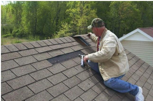
Ремонтом крыши гаража, покрытой гибкой черепицей, занимаются при температуре воздуха не менее +5 °С. Сначала нужно найти повреждённый участок. Чаще всего дефекты встречаются в местах примыкания к трубам и стенкам, а также во внутренних углах крыши.
