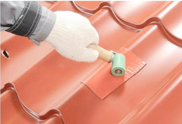
Такие ленты подходят для заделывания небольших повреждений до 5 см. Они хорошо повторяют волны на поверхности металлической черепицы и обеспечивают хорошую герметичность. В результате на месте повреждённого участка талая или дождевая вода не смогут попасть под кровельный материал.
